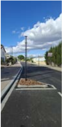
Vue sur la Voie romaine communale rénovée
