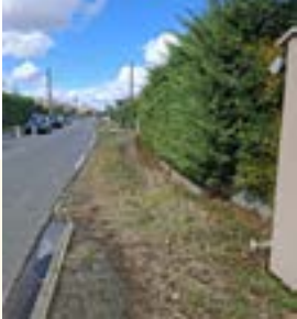
Vue sur les aménagements de trottoir à venir Rue de la Voie Romaine
