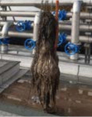
Lingettes agglomérées autour d'un équipement : une des principales causes de dysfonctionnement en station d'épuration
