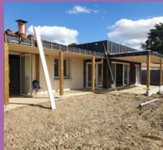
Travaux futur EVS
