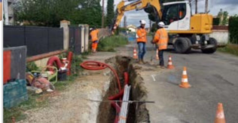
Travaux sur la Voie Romaine
